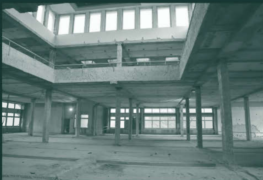
Rekonstruojami Radastų g. rūmai. 2022 m.
