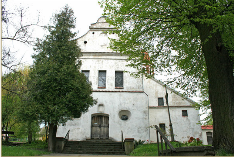
Šv. Mikalojaus (benediktinių) bažnyčios pastate (Šauklių g. 8), 1963–1990 m. buvo įrengta knygų saugykla. 1990 m. pastatas grąžintas vienuolių benediktinių kongregacijai. 2010 m.
